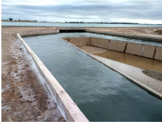
Imagen 19. Entrada a los reservorios: vertedero pico de pato.
