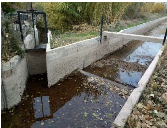
Imagen 24. Toma donde se modificará la sección de aforos.
