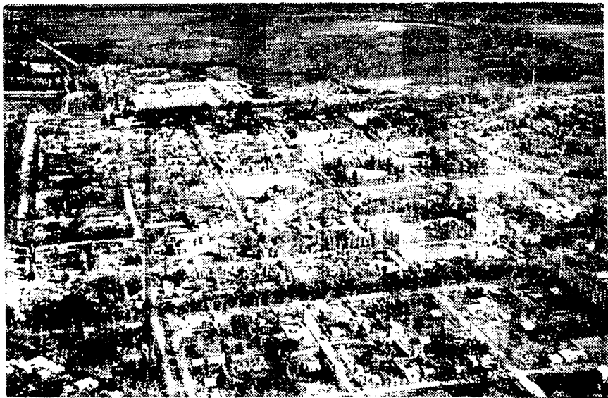
Fot. 55 — Villa Atuel y Bodega Arizu S.A. (al fondo), la más amplia en el sur de la provincia de Mendoza. Tercer núcleo en importancia en el oasis, el trazado urbano tiene cierta densidad de ocupación alrededor de la plaza central.
