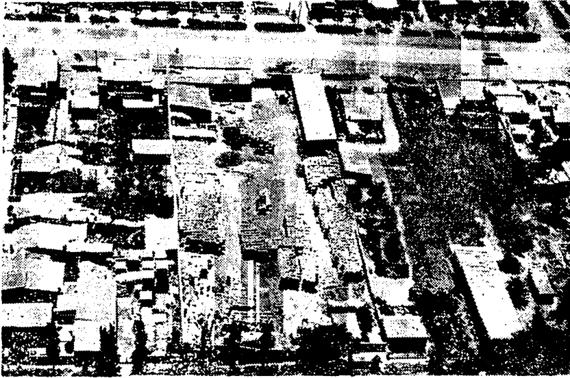
Fot. 44 — Aserradero y carpintería en el barrio Libertad (Pueblo Diamante) a lo largo de la calle principal (sector E). Importante industria local de fabricación de cajones sobre todo, ubicada en pleno barrio residencial.
