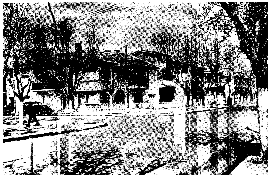
Fot. 62 — Viviendas modernas de dos plantas frente a la plaza San Martín. En la zona céntrica, donde el terreno alcanza un alto precio, la edificación de casas de dos plantas duplica el espacio disponible.
