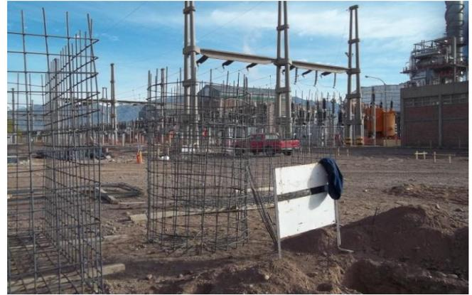
Fig. 2 - Preparación armadura de bases de pórticos y equipos.
