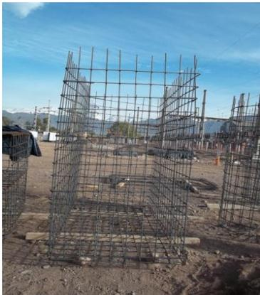
Fig. 1 - Preparación armadura de bases de pórticos y equipos.
