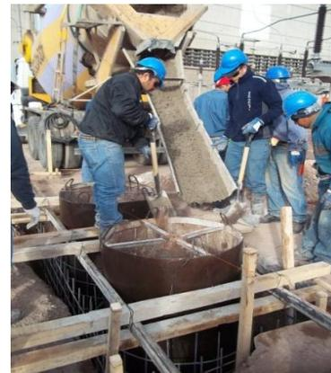
Fig. 6 - Hormigonado fundación C11.
