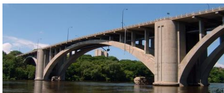
Figura 2.4. Puente de arco semielíptico. Ejercicio 81.
