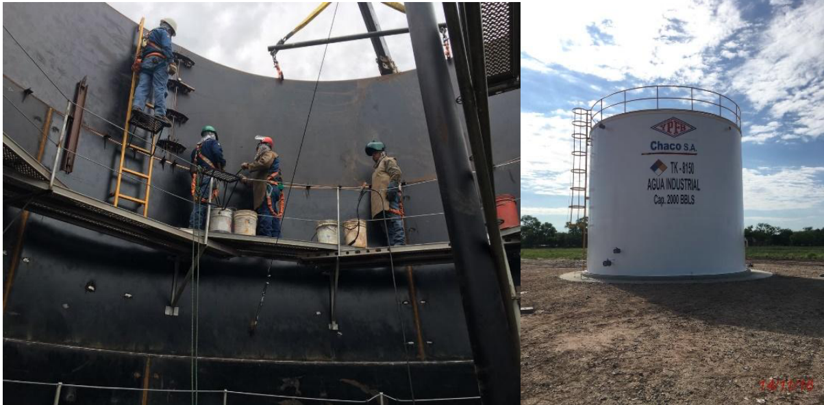
Imagen 4 y 5: Construcción de tanque API para almacenamiento de agua en Caigua, y tanque terminado para YPFB CHACO S.A. Data Book tanque Caigua 2017.
