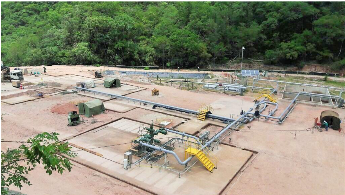
Imagen 6: Facilidades de superficie, construidas en Pozo Sábalo 14 del activo San Antonio, para Petrobras Bolivia bajo la modalidad de "llave en mano". En octubre del 2019 abrió la válvula de producción temprana de este pozo, quien era el presidente de Bolivia, Evo Morales Ayma. . Data Book pozo SBL 14 2018.
