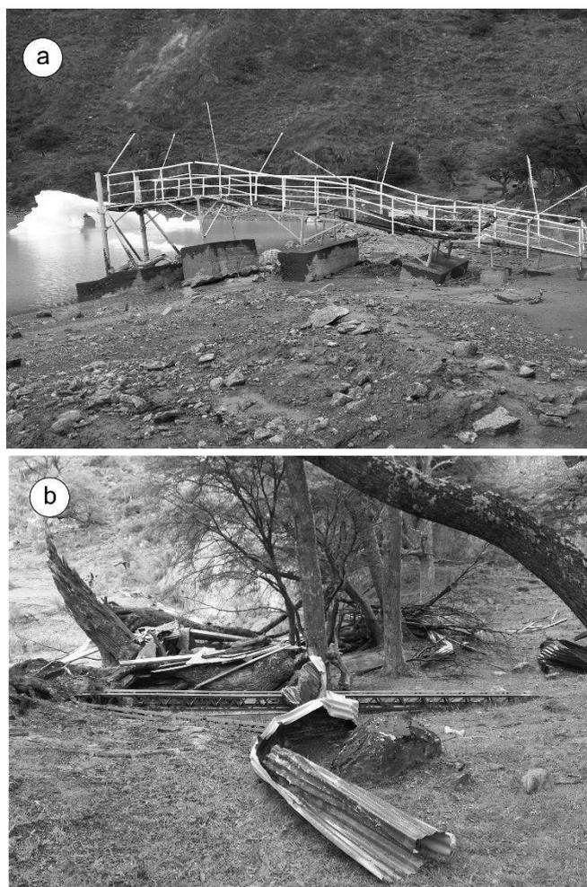
Figura 11.7. a) destrucción del embarcadero de bahía Onelli como consecuencia del seiche del 10-02-2013 producido por el deslizamiento de ladera ocurrido en la ladera oeste del brazo Upsala. b) Parte de la estructura del embarcadero fue arrojada bosque adentro por la fuerza de la ola, produciendo la caída y ruptura de árboles.
