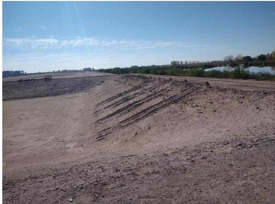
Figura 13 Lagunas de estabilización en construcción (izq.) y existentes (der.)
