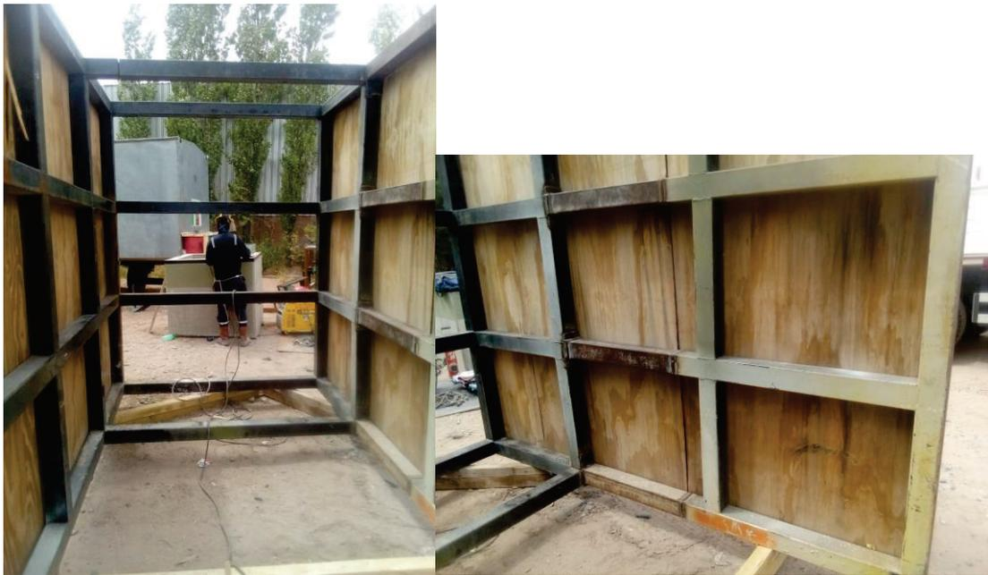
Fig. 17: Estructura de entablicado en elaboración
