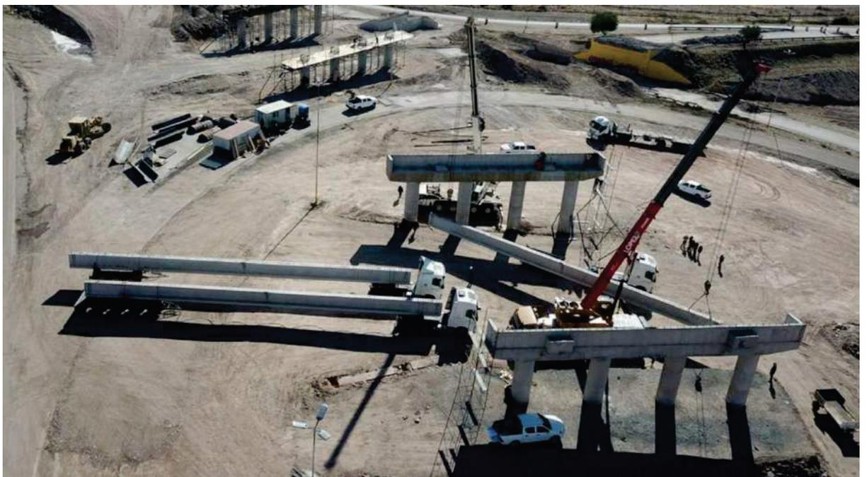
**Figura 31: Momento previo a montaje de viga puente.**
