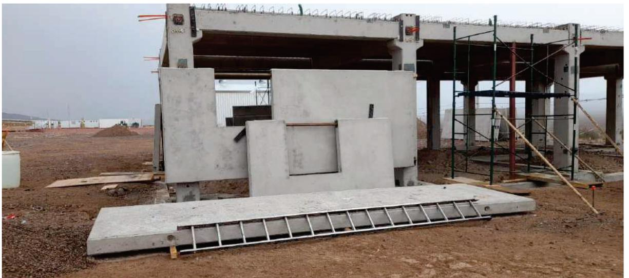
**Figura 26: Montaje paneles de cierre.**
