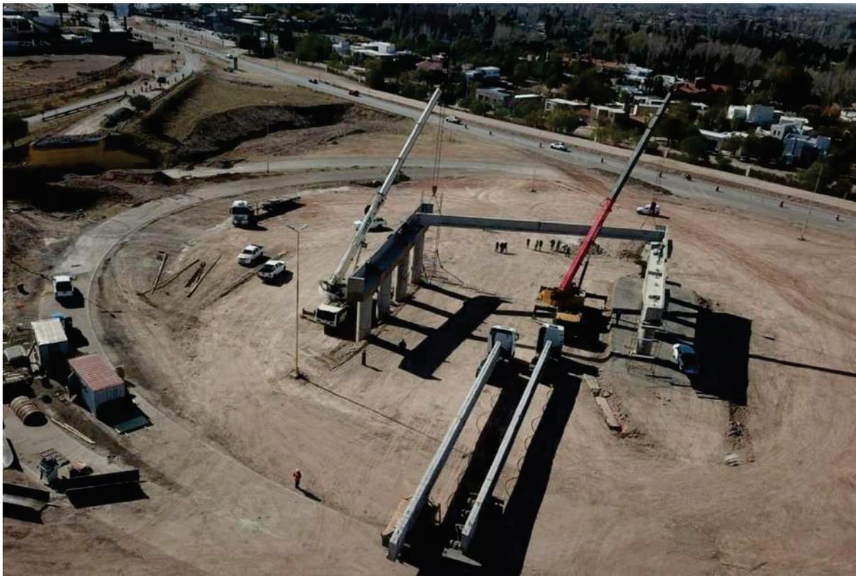
**Figura 32: Montaje de primer viga de puente.**
