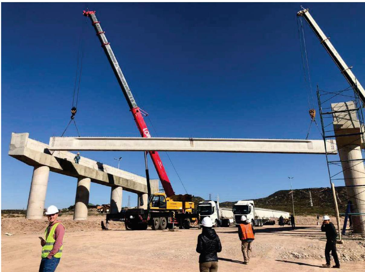
**Figura 33: Montaje viga puente.**
