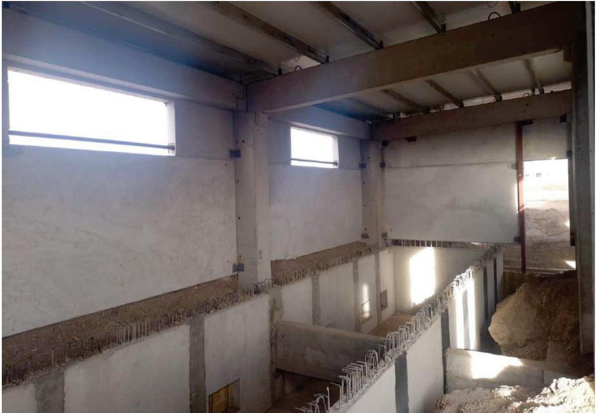
**Figura 28: Trincheras para alojar cables.**
