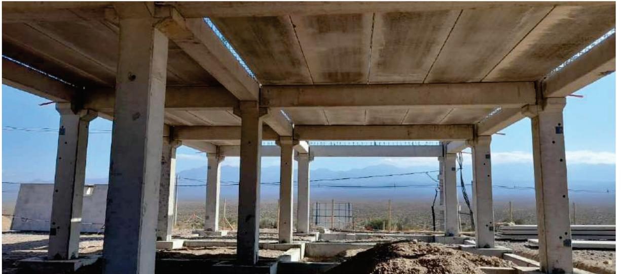
**Figura 25: Montaje losas huecas premoldeadas.**
