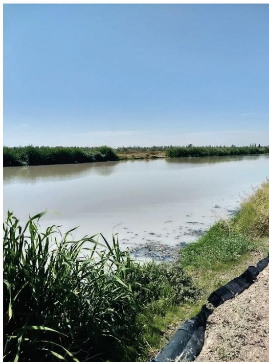
*Figura 9. Laguna de estabilización. Observe la barrera impermeable de polipropileno vandalizada.*
