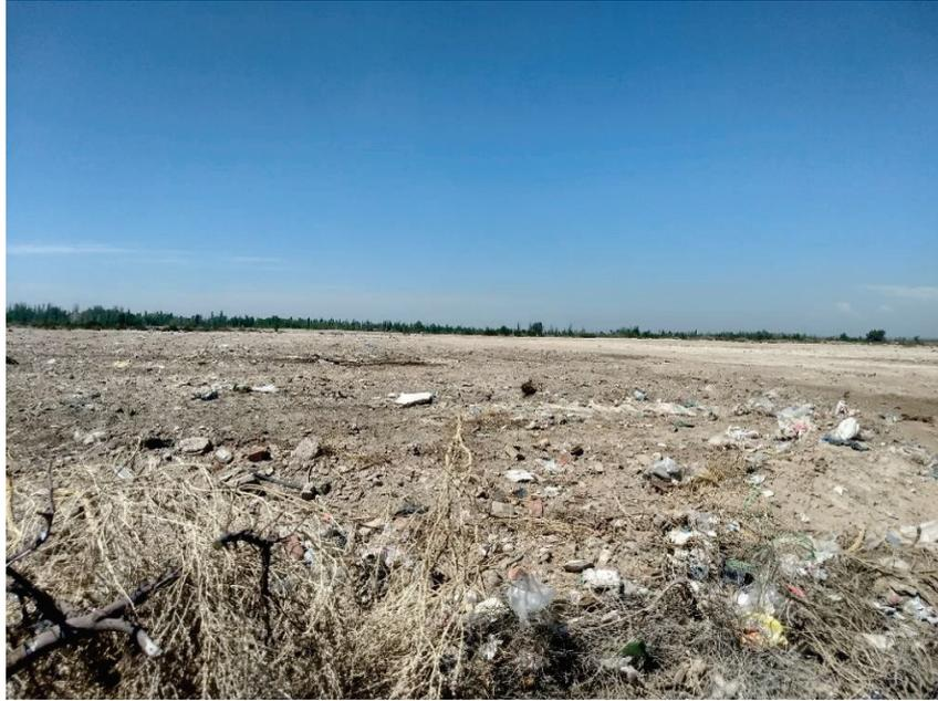
*Figura 6. Vista de una de las áreas del vertedero. Como consecuencia de lo comentado en el primer párrafo se concluye que cualquier movimiento de suelo en el terreno traerá a la superficie RSU.*
