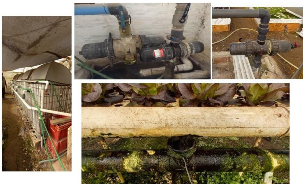
Figura 20: Tanques con criaderos de truchas (izquierda). Filtros de mallas en distintos lugares del sistema y filtrado grueso a la salida del sistema NFT al sistema recolector de
