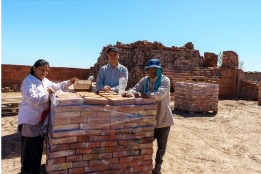
Ilustración 128 – “Con Primitiva Quispe y Alfredo Padilla. Ladrillos de El Algarrobal (2ª parte) sobre pallet de ladrillos”, El Algarrobal, 2023.
