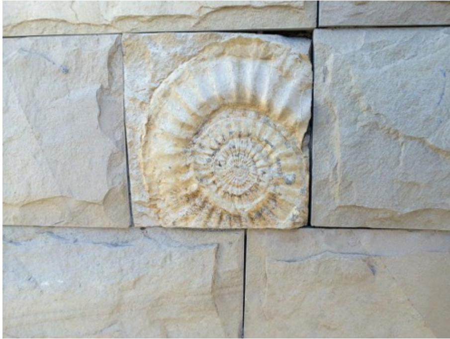
Ilustración 94 – “Fósil de amonite en la fachada de una edificación”, Zapala, 2014.
