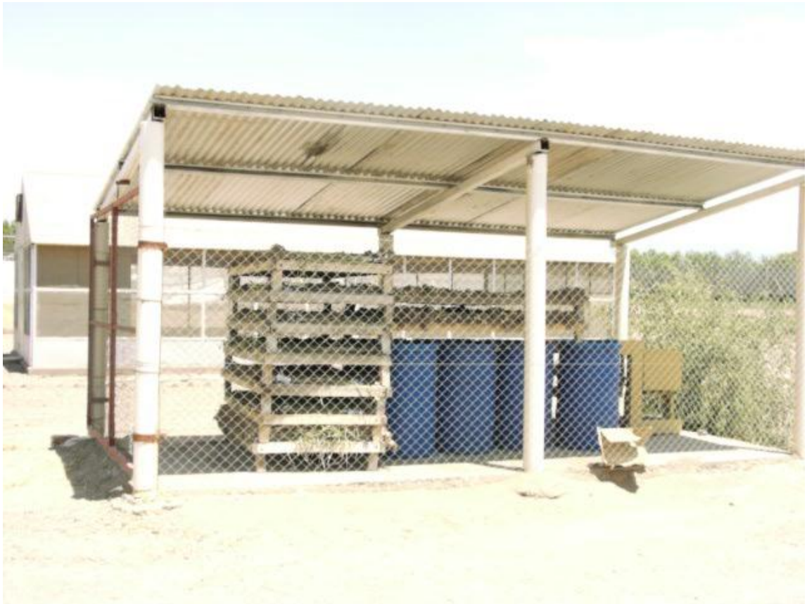
Figura 24: Vista general del área donde se produjo el “curado” de los bulbos. Éstos se encuentran atados y rotulados sobre las zarandas. Fotografía tomada 19 de Diciembre de 2003.
