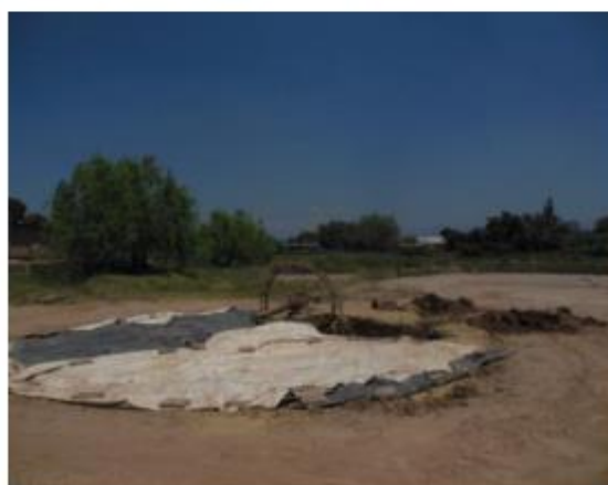
Figura 3. Elaboración de la pasta base durante la fabricación de ladrillos Fuente: Estudio Socioambiental de la Producción de Ladrillos Artesanales en Mendoza desde la Perspectiva del Análisis de Ciclo de Vida (UTN)
