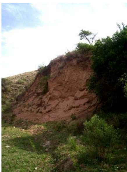
Imagen 7. Talud vertical con socavamiento en su parte media y baja
