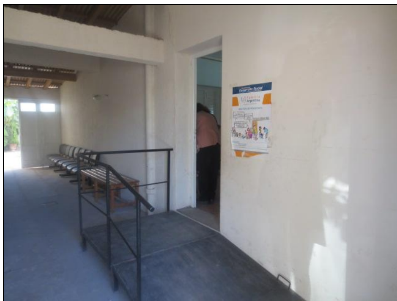
Acceso al Área de Discapacidad
