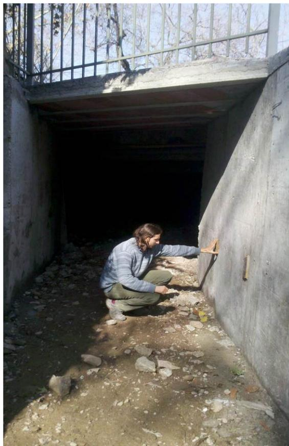
*Figura 38: Revisión de juntas y posibles fisuras.*
