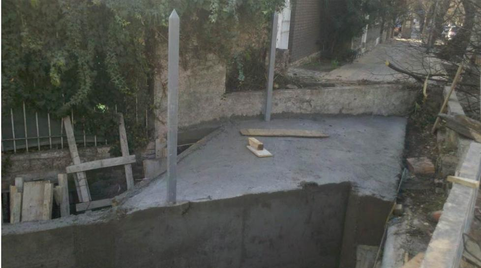
*Figura 37: Puente canal desencofrado.*
