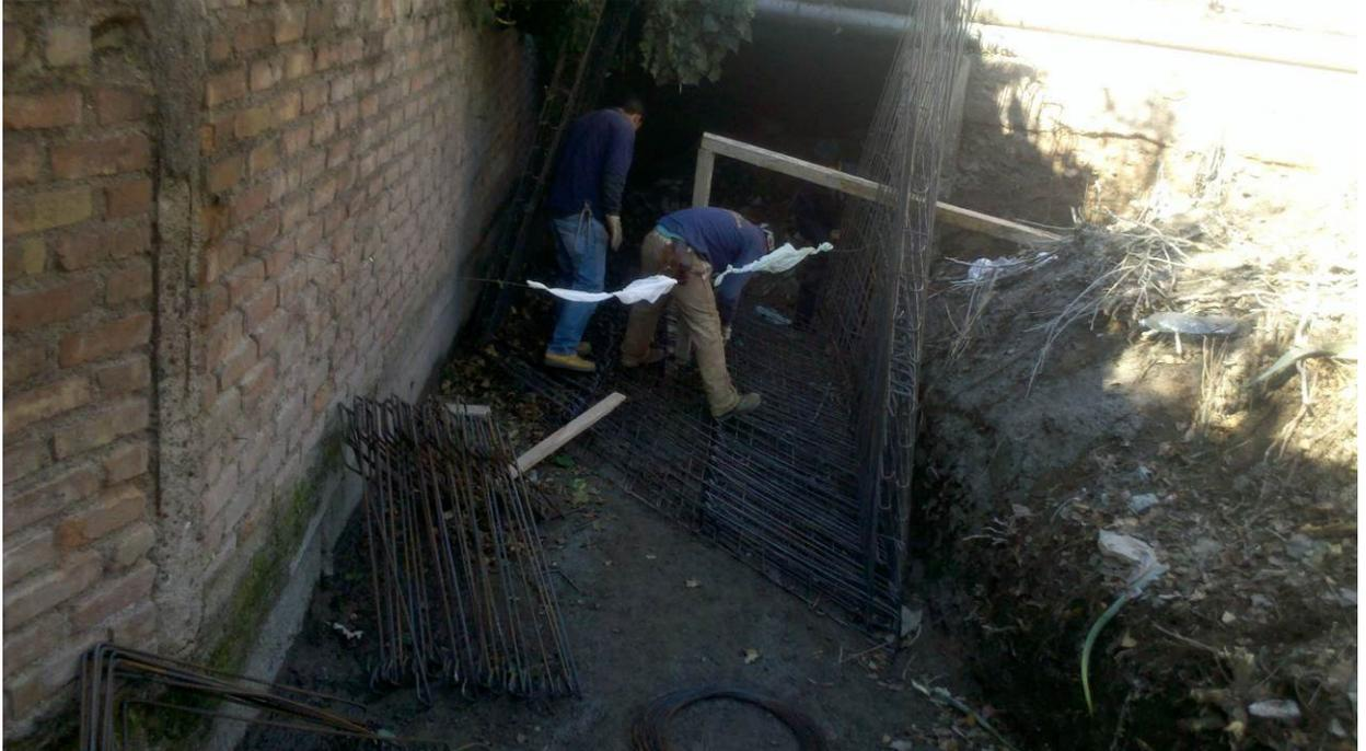
*Figura 31: Obreros posicionando la armadura traída desde el sector de armado.*
