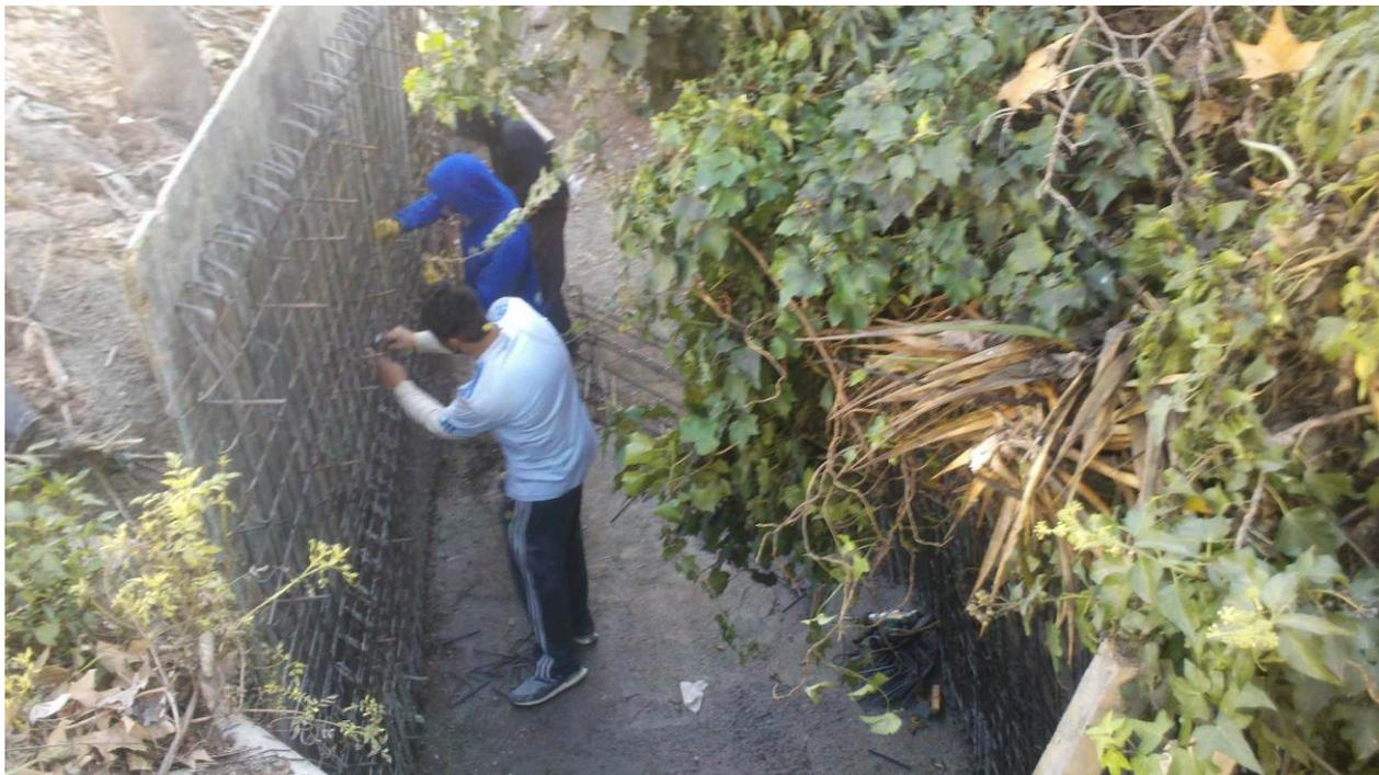
*Figura 35: Construcción de encofrados laterales.*
